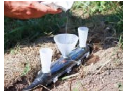
Verguss des Zweikomponenten-PUR-Gießharzes
